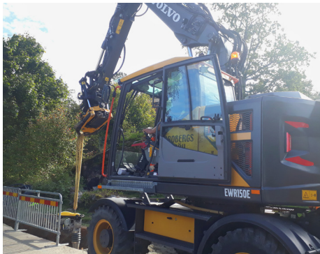
De första grävtagen är tagna för rörläggningsarbetet vid Skarsjövägen. Foto: Sanna Brobjer
