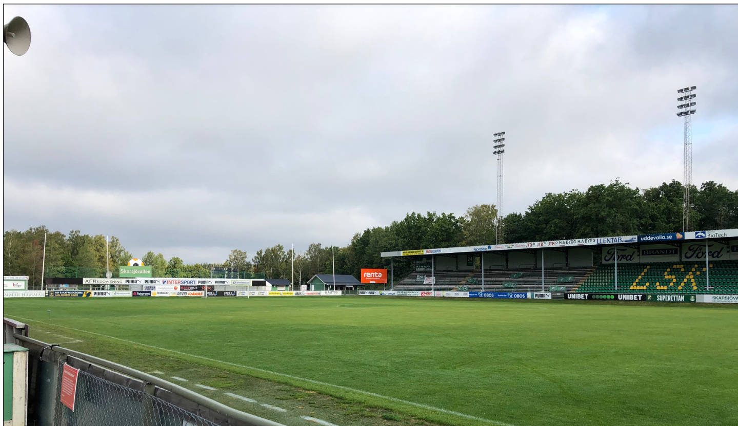
Delar av Skarsjövallen behöver åtgärdas för att arenan ska kunna vara fortsatt spelbar i Superettan.
